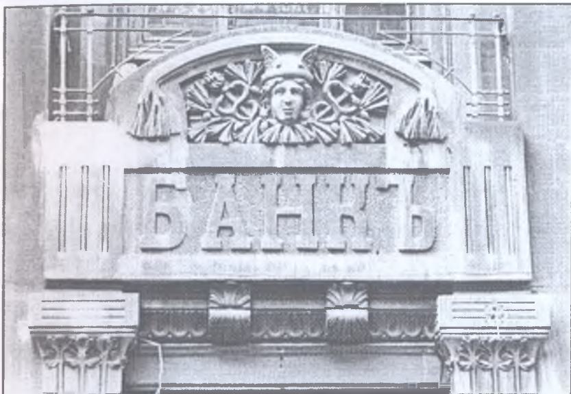
Bakıda Şimal bankının binasının fasadı (1903-1905-ci illər)
