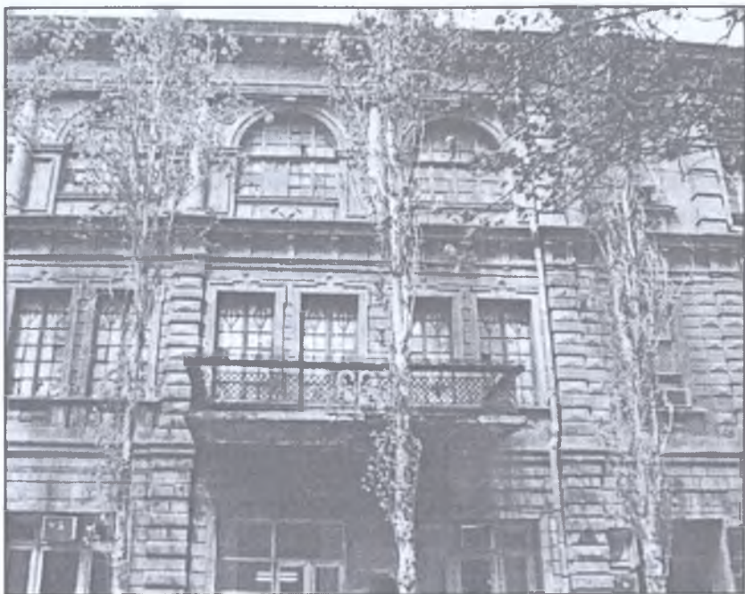
H.Z.Tağıyevin kommersiya bankının yerləşdiyi bina
